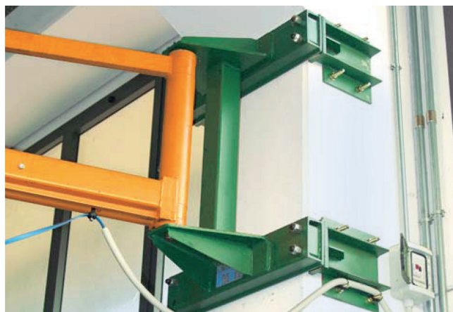
Imbragatura mediante tasselli chimici. Chemical bolts anchoring.
